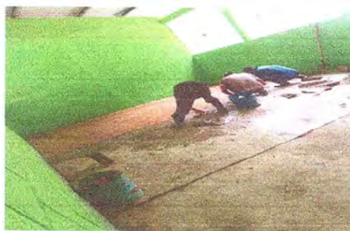
Foto 11: Colocación de Pisos
