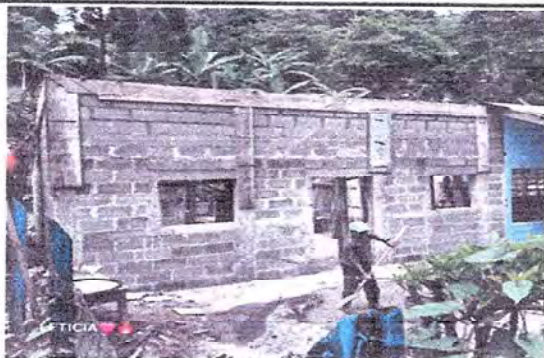
Foto 7: remodelación de Cocina
