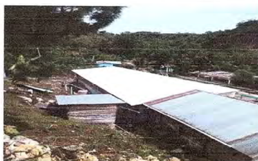
Foto 6: Desinstalación de canales
