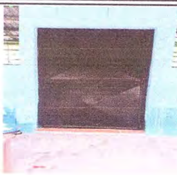
Foto 8: Mantenimientos de puertas
