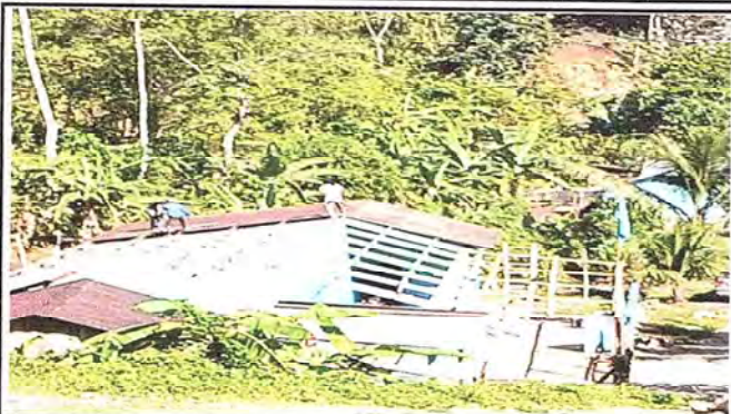
Foto 1: Desinstalación de laminas
