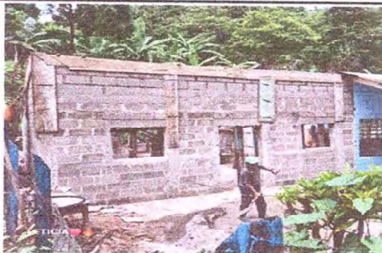
Foto 7: remodelación de Cocina
