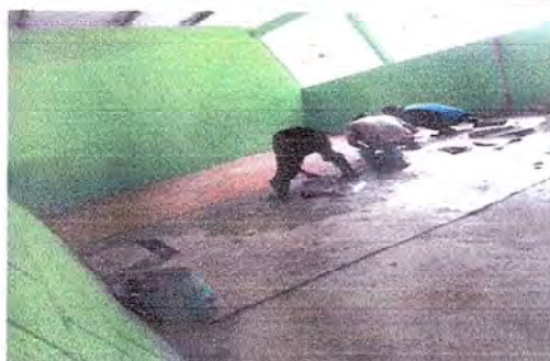
Foto 11: Colocación de Pisos
