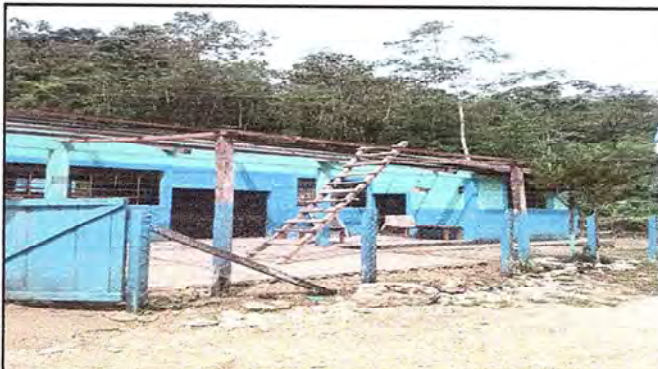
Fot 4: Pintura de las costaneras y vigas
