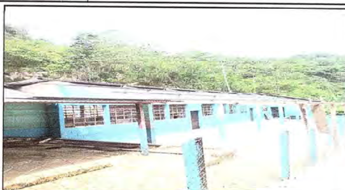
Foto 2: Desinstalación de láminas
