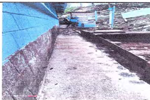
Foto 12: Fundición de losa de patio
