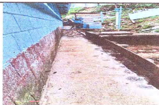
Foto 12: Fundicion de losa de patio
