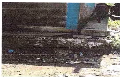
Foto 5: Desinstalación de canales
